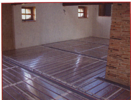
Les tubes sont insérés dans les rainures des dalles d'isolation
