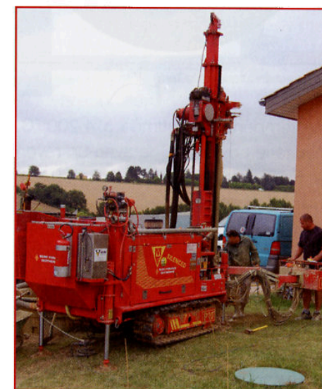
Forage sur sonde géothermique en rénovation
