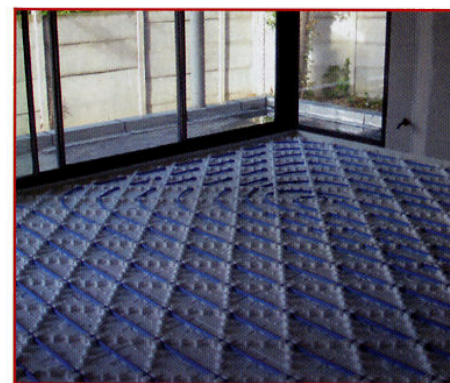
Plancher chauffant Acome avant coulage de la chape liquide
