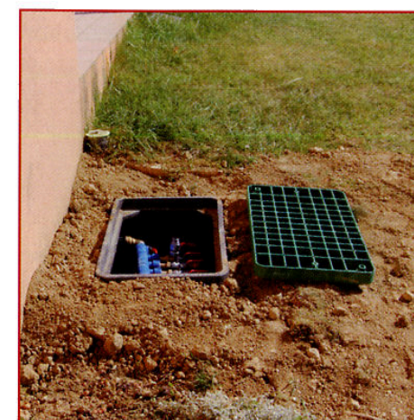
... et résultat final. Le regard permet de raccorder les sondes pour les connecter sur un collecteur.
